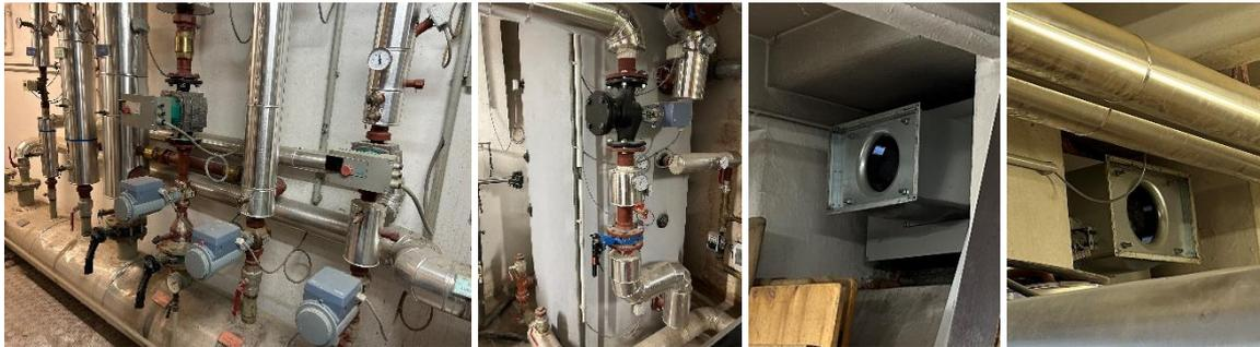
✓ Es werden großteils energieeffiziente frequenzgesteuerte Pumpen eingesetzt.
